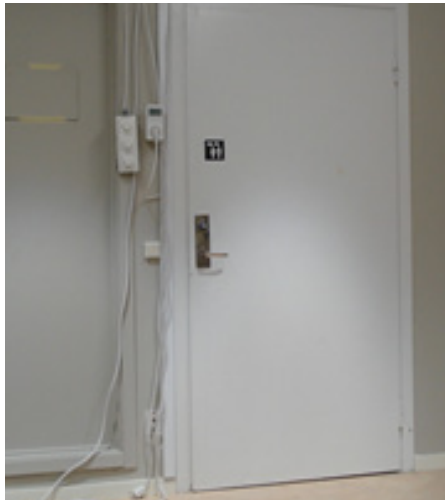
Figur 9. Dimmers monterade på bärbar dosa med lång sladd, och wattmätaren monterad vid dörren.
